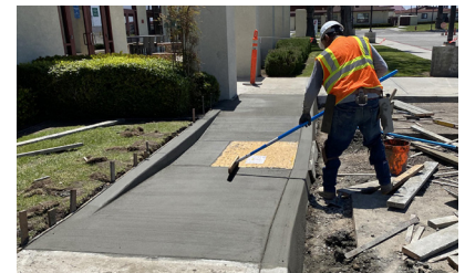
ADA ramp construction
